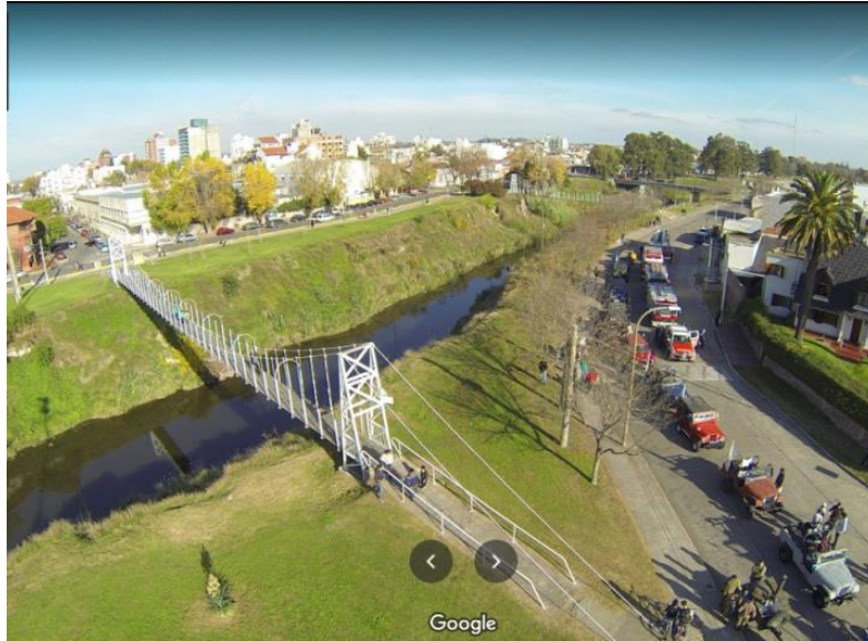
Fig. 66 Google maps – (2022) – vista aérea puente colgante - https://www.google.com.ar/maps
